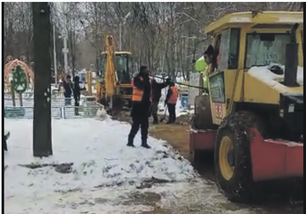
Зима. Укладка плитки
